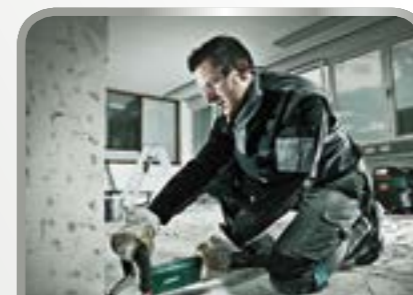
Ponçage et tronçonnage
