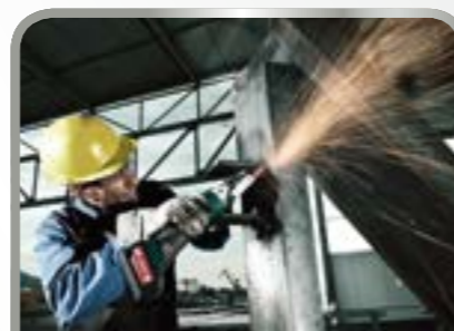
Ponçage et tronçonnage
